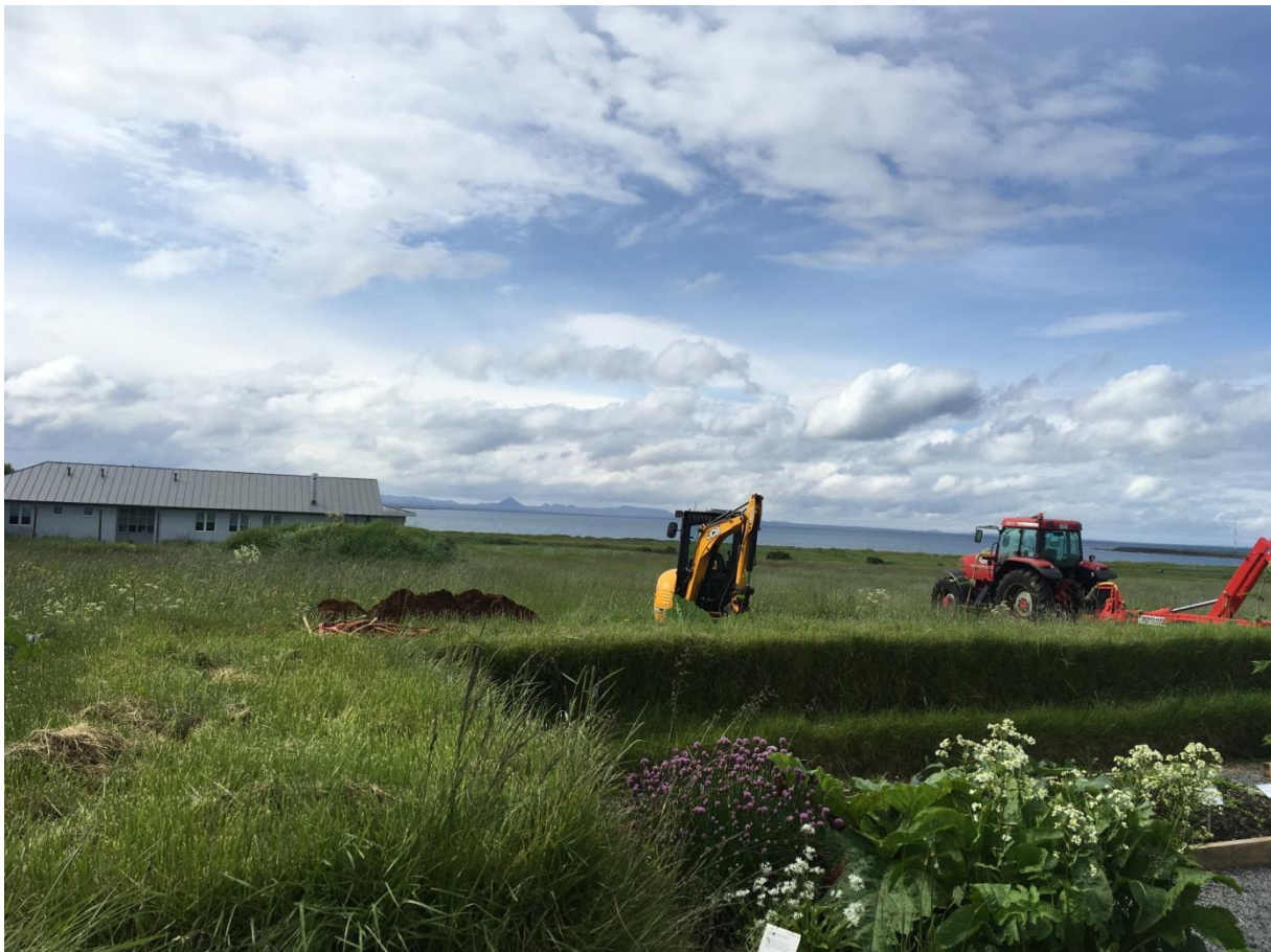
Mynd 4. Unnið að gerð könnunarskurða. Tekið úr núverandi Urtagarði til suðurs.
