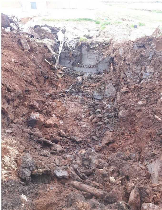
Mynd 3. Rústin eftir að mýkja hafði verið mokað upp. Rústin verður svo fyllt af grús.
