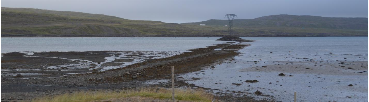
Mynd 25. Rafmagnslína sem liggur yfir Þorskafjörð. Tekið í suðaustur, í átt að Kinnarstöðum. Sami útsýnisstaður og á Þrívíddarmynd 10. Mynd: NAVE/HBA.
