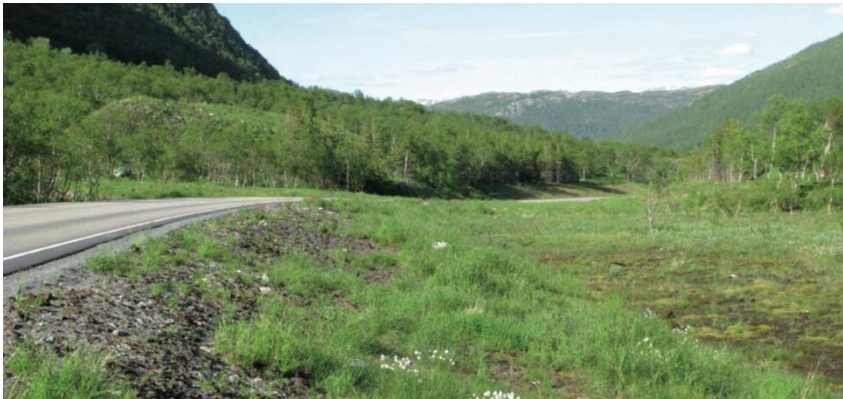
Mynd 2. Aflíðandi flái fellur mun betur að landslaginu heldur en stífmótaður aflíðandi halli þótt hann sé þá aðeins breiðari. Myndir frá Lofoten úr skýrslu Kongsbakk og Skrindo 2009.
