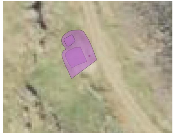
Mynd 29. Stekkurinn hefur orðið fyrir miklum skemmdum en er ekki í hættu vegna veglagningar.
