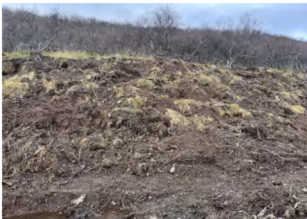
Gróðurtorfur og svarðlag jafnað yfir skeringu.
