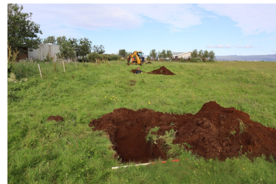
Framkvæmdarsvæði við götuna Hjalladæl á Eyrarbakka.
