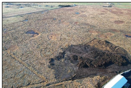
Mynd 3. Búið er að ryðja töluverðum jarðvegi inn á framkvæmdasvæðið.
