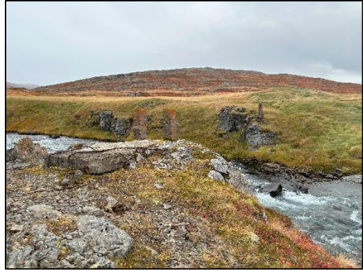
Mynd 49. Horft SA yfir brú 3121-031.
