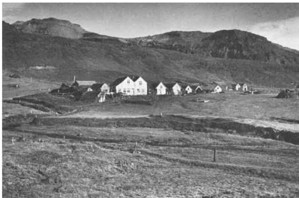
Mynd 5. „Vestur-hjáleiga árið 1954. Samkvæmt Gísla, heimildamanni, var bærinn yfirgefinn árið 1963 þegar nýtt íbúðarhús var byggt á öðrum stað“ (Gylfi Helgasson. 2023.bls. 17. Ljósmynd: Magnús Björnsson. (1976). Bls. 61.
